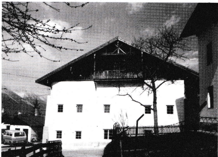
Daß ein altes und baufälliges Bauernhaus nicht gleich abgerissen werden muß, zeigt die mustergültige Renovierung des alten Bieringer Hofes in Axams (Besitzer Franz und Anna Bucher). Für das Ortsbild sind derartige Initiativen sehr wichtig.
