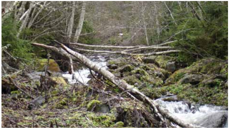
Um einen ungehinderten Abfluss zu gewährleisten, muss von Zeit zu Zeit der Bewuchs aus dem Bachbett entfernt werden.
