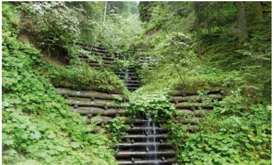
Regulierungsbauten, wie hier im Fußtal, werden jährlich vom Waldaufseher auf ihren Zustand überprüft.
