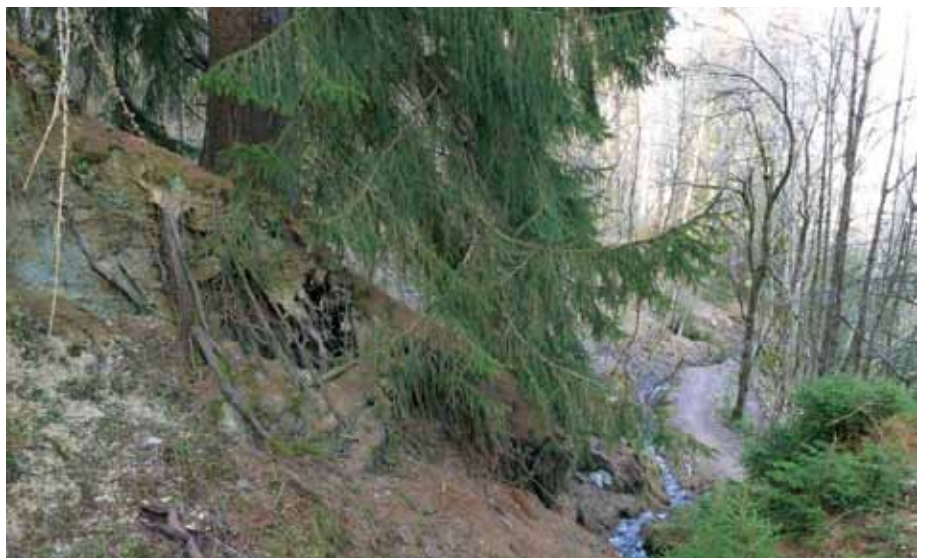
Unterspülte Bäume, wie hier im Bereich Rieder müssen entfernt werden.
