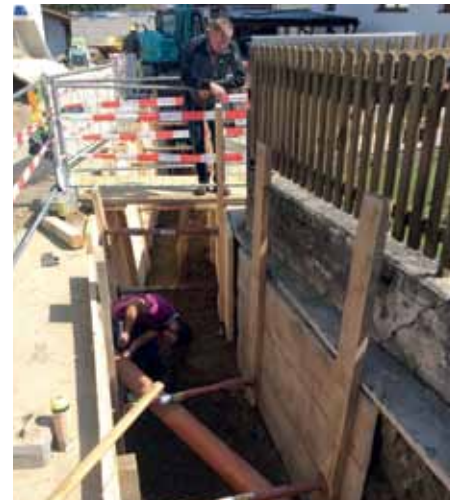
Sämtliche Hausanschlüsse wurden mit einem eigenen Schieber neu angeschlossen.
