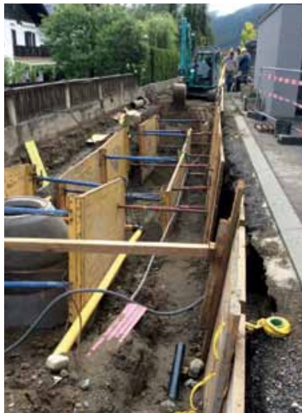
Sämtliche Leitungen werden neu verlegt.
