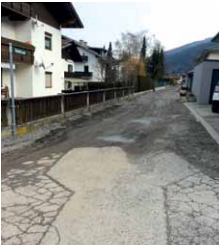
Schießstandweg vor Baubeginn
