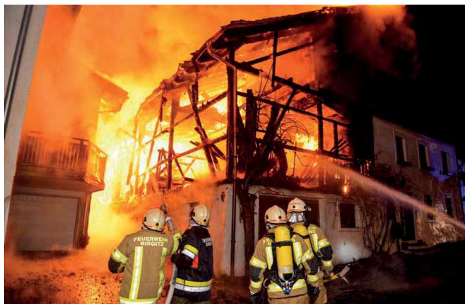
Sofort schlugen die Flammen auf ein nur 3 m entferntes Nachbargebäude über.
