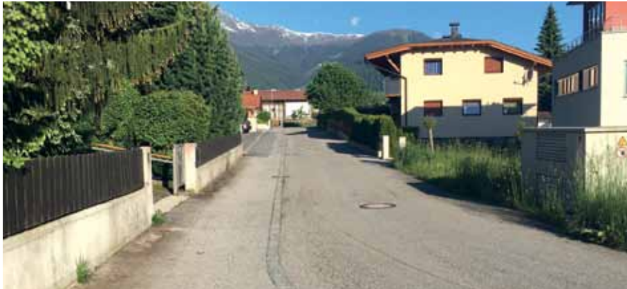
Miselsstraße in Blick Richtung Westen vor Beginn der Bauarbeiten
