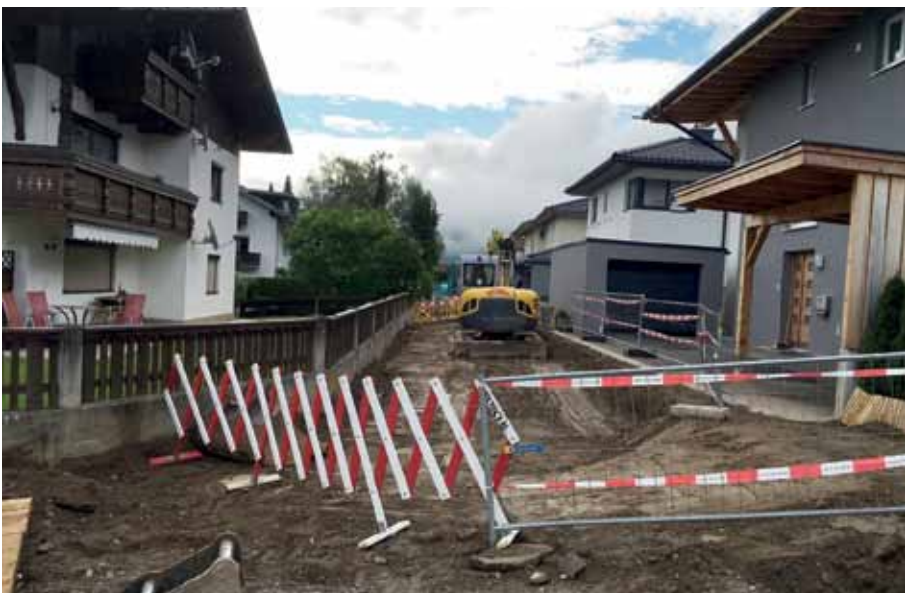
Diverse Grabungsarbeiten am Schießstandweg (Blick Richtung Osten)
