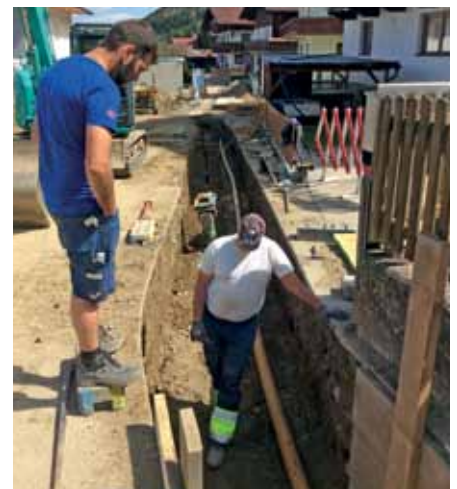
Auch Glasfaserkabel wurde mitverlegt.
