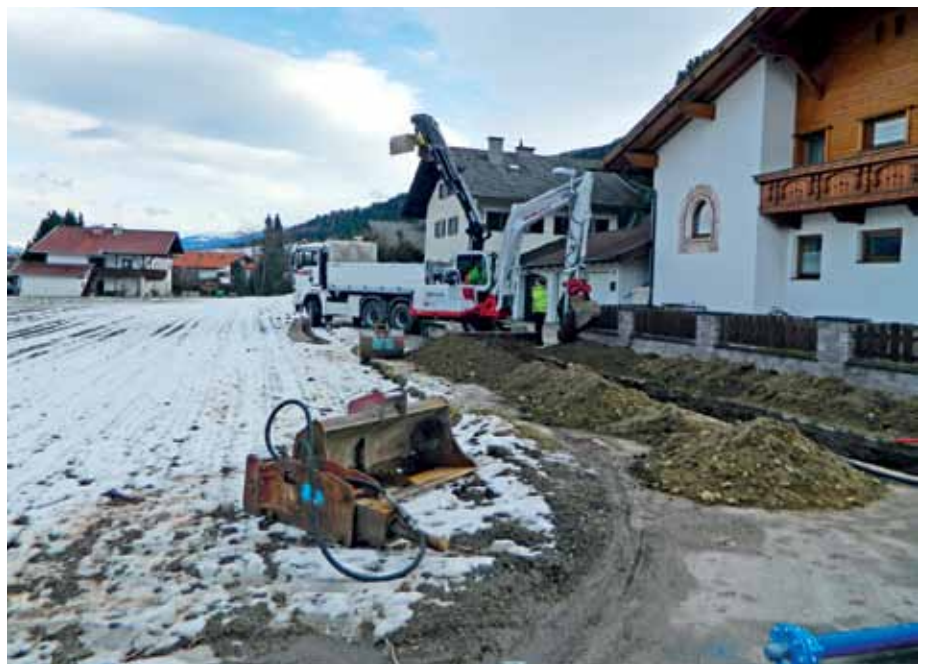
Die Wasserleitung wurde bereits getauscht.
