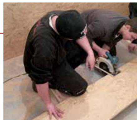
Fleißige Helfer bei den Umbauarbeiten
