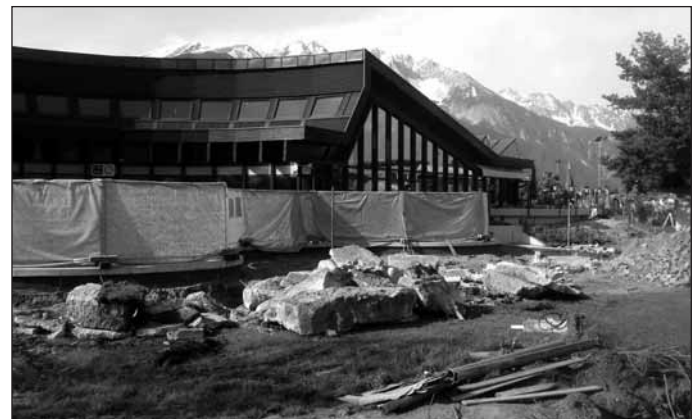
Sanierungsarbeiten am bestehenden Außenbecken
