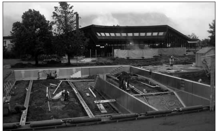
Errichtung des Nirostbeckens im April 2006
