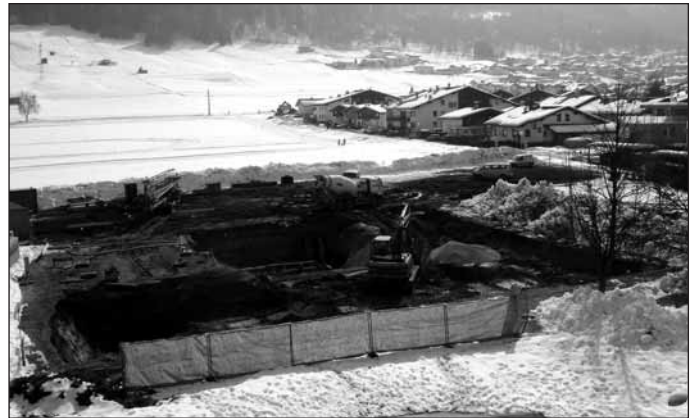
Beginn der Aushubarbeiten im März 2006
