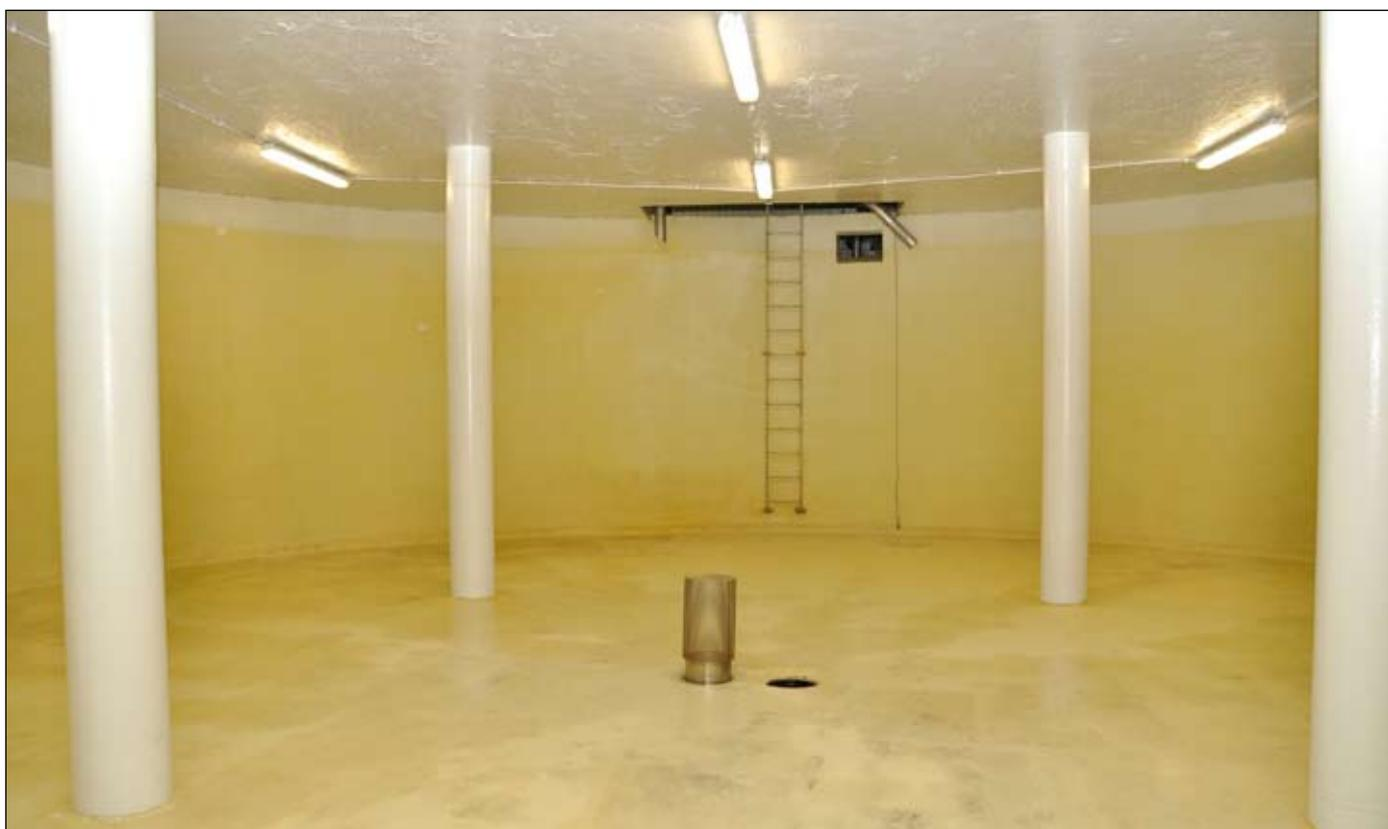
Die zu sanierende Fläche (Wände und Boden) der Behälterkammer beträgt rund 270 m<sup>2</sup>: Durchmesser 12 m, Höhe 4 m, Nutzinhalt 500 m<sup>3</sup>
