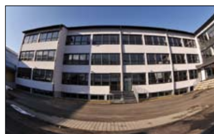
Südansicht der sanierten Hauptschule
