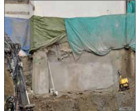
Detailansicht Spritzbetonsicherung
