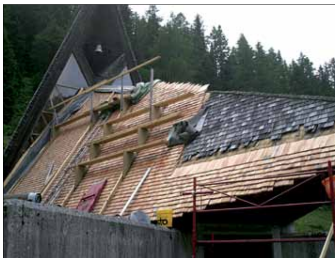
Die Lizumkapelle während der Sanierungsarbeiten...
