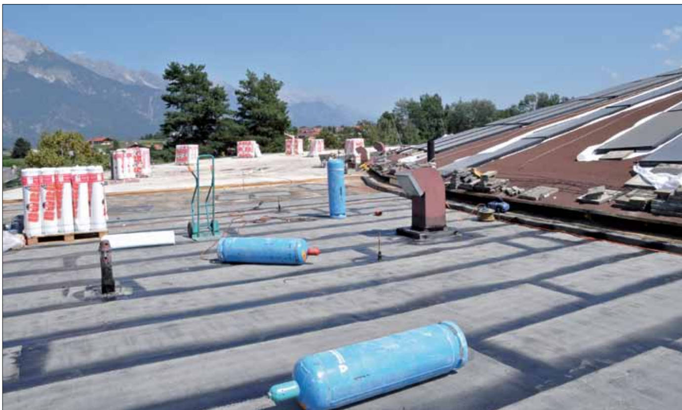
Flachdachsanierung
