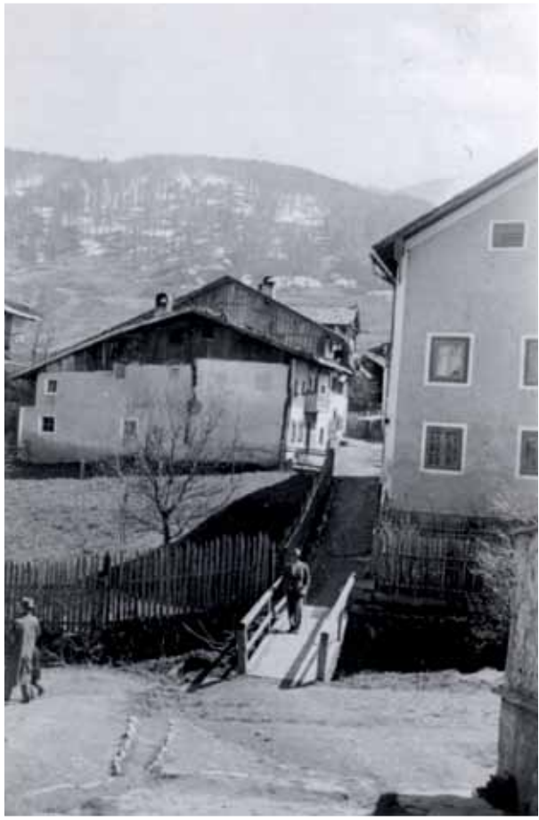
■ Bachbrücke bei der Silbergasse, Mai 1941
