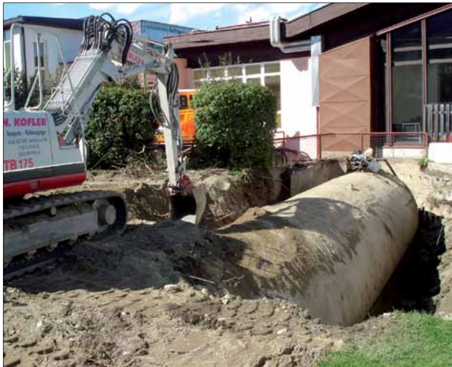
Entsorgung des Öltanks
