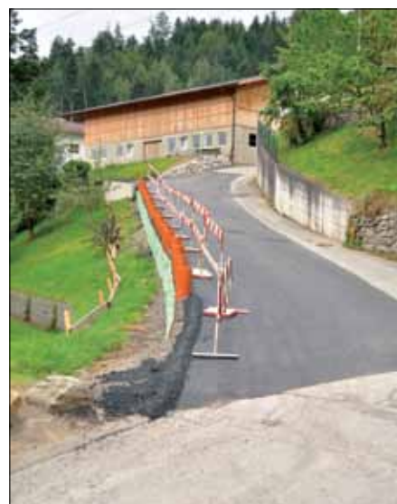
Kurz vor Fertigstellung
