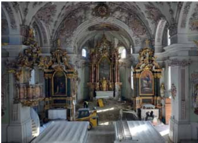
Bei den Grabungsarbeiten im Altarraum wurden Skelette gefunden
