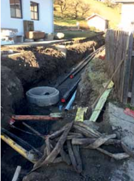
Sämtliche Leitungen wurden bereits verlegt.
