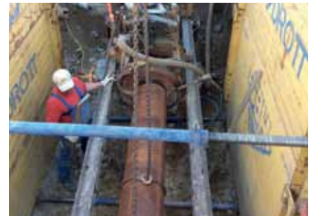
Durchpressen der Wasserleitung im Bereich Zifres
