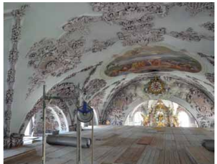
Einrüstung „oberstes Geschoß“
