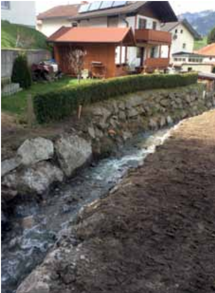
Die Ruifachbach-Verbauung ist fertiggestellt.
