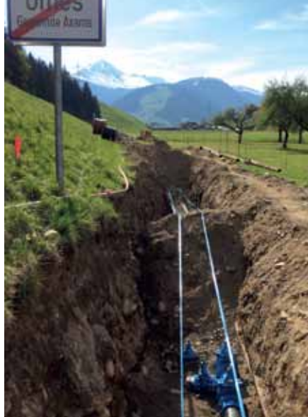
Neue Hauptwasserleitungen Fotos: Ing. René Sarg
