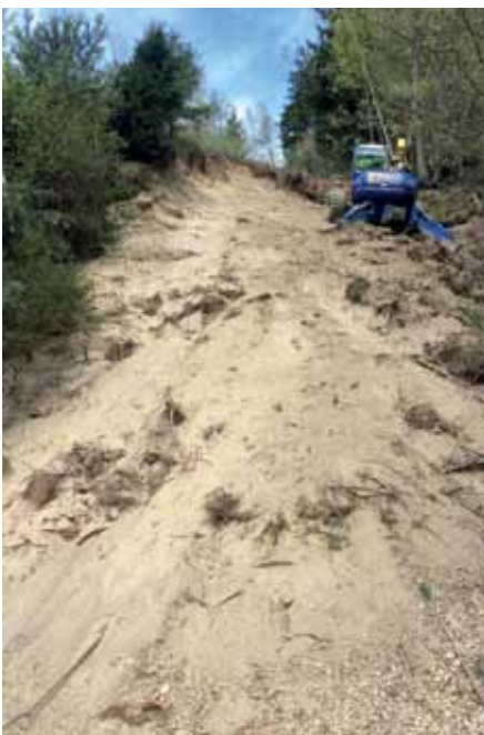
Grabungsarbeiten mittels Streitbagger
