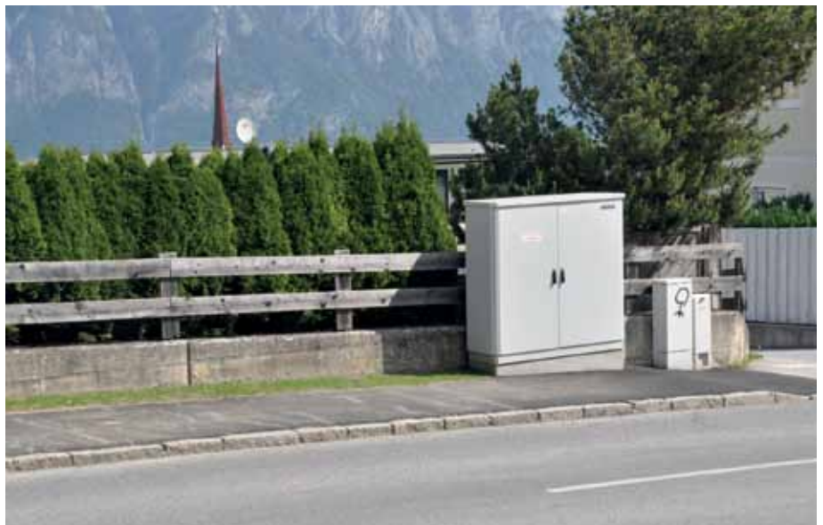
Die Gemeinde Axams unterstützt den Breitbandausbau – so sehen die neuen Glasfaserversorgungskästen aus (Beispiel Wiesenweg/Olympiastraße).
