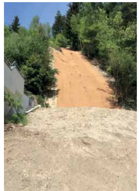
Kokosmatte als Erosionsschutz
