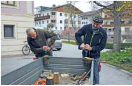
... viele Löcher gebohrt werden, ...
