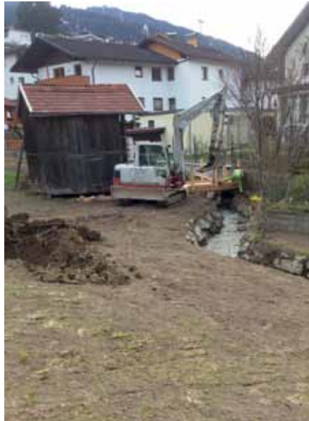
Die Bachbrücke wurde erneuert.
