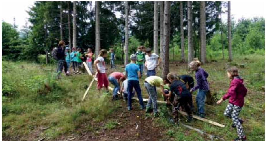
Beim Bau der Waldkugelbahn waren die Kinder mit besonderem Eifer dabei.
