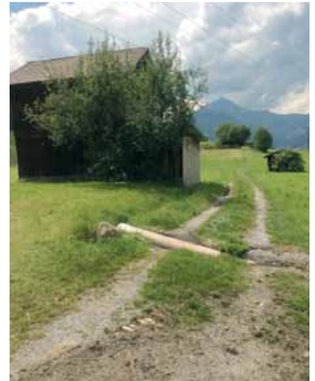
Auf Feldwegen wie hier im Bereich „Misl/Steigäcker“ wurden Rohre freigespült.
