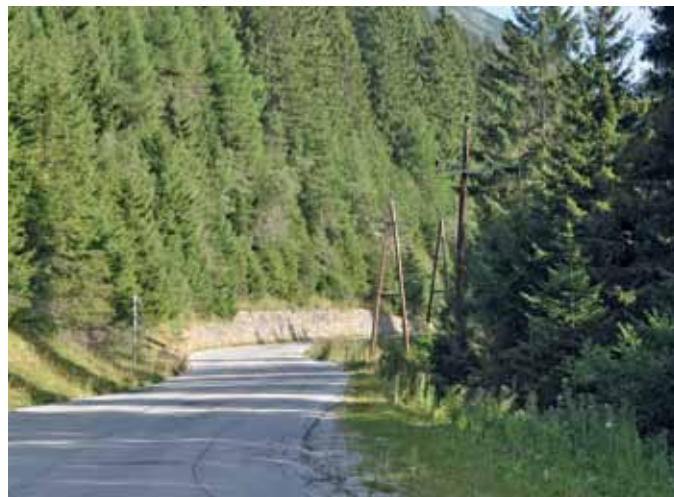
Das Entfernen der Freileitung entlang der Hoadlstraße erleichtert die Waldbewirtschaftung.
