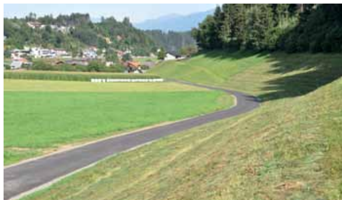
Die Verlegung der neuen Trinkwasserleitung im Gemeindegeweg „Plocha“ in Omes ist bereits abgeschlossen.
