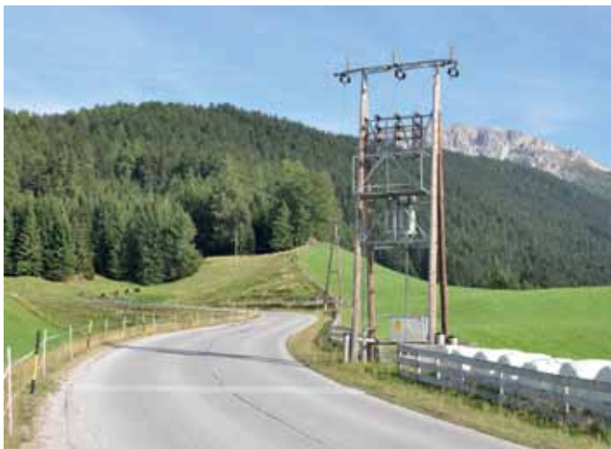
Beginnend von der Kehre beim Adelshof wird die Stromleitung unterirdisch verlegt.
