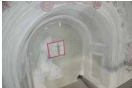
Die „aufgemalten Fenster“ im Altarraum wurden freigelegt ...
