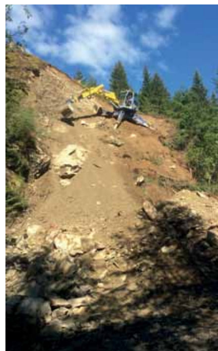
Aufwändige und gefährliche Hangsicherungsmaßnahmen mittels eines Schreitbaggers waren erforderlich.
