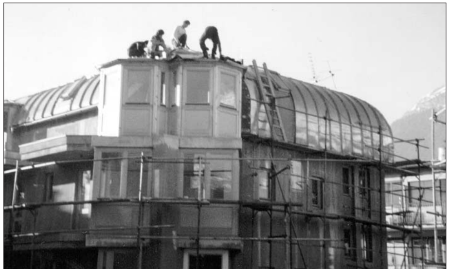
Dacharbeit auf einer Baustelle der Firma Unterkofler.
