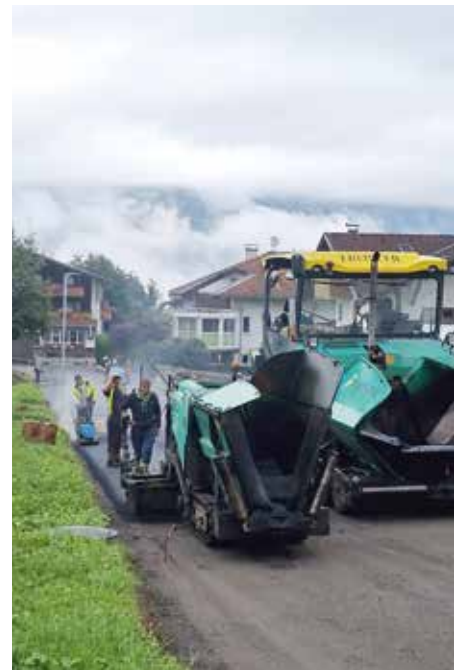
Asphalteinbau mit zwei Asphaltfertiger
