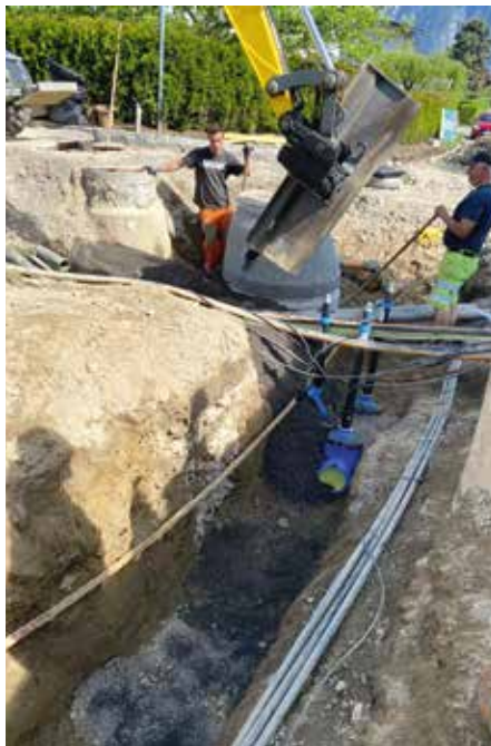
Einbau des Wasserschieberkreuz
