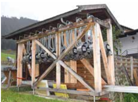
Holz Zubau zum Verwahren der Bügel während des Sommers.
