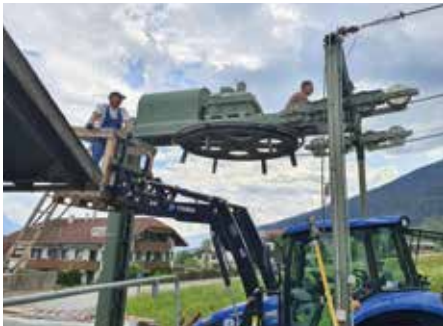
Für die Arbeiten am Seil (z. B. Auf- und Abhängen der Bügel) wurde ein Arbeitskorb angeschafft.
