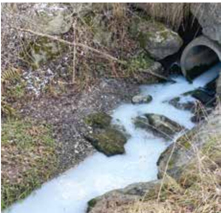
Verunreinigung im Ruifachbachl Axams
