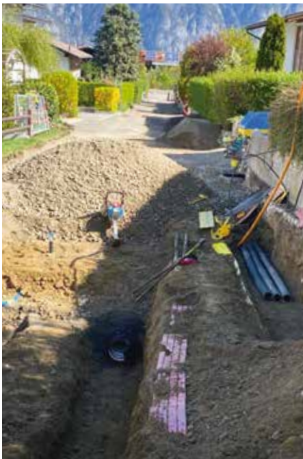
Grabungsarbeiten der Leitungen
