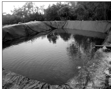
Das erste Auffangbecken füllt sich. Fassungsvermögen: 450 m 3 Wasser
