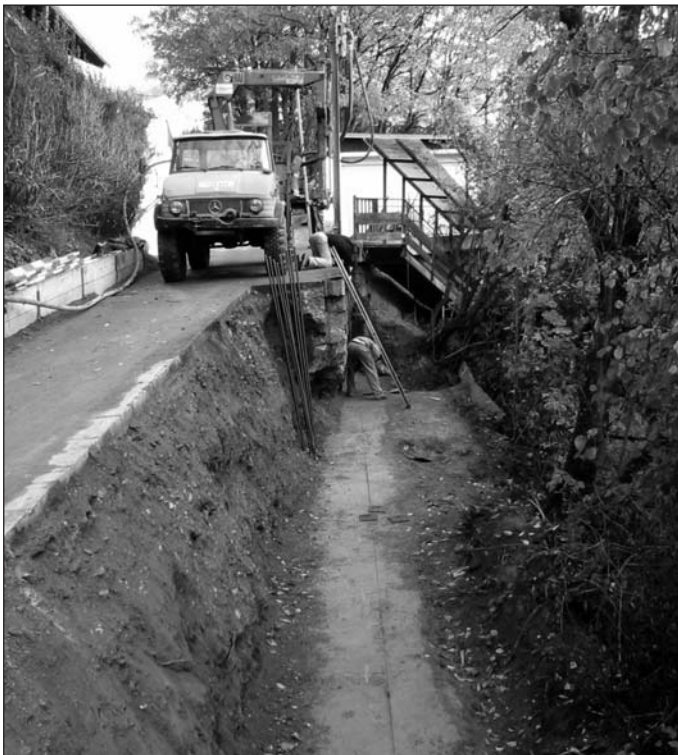
Wegverbreiterung und Hangsicherung im Bereich Kristen/Föhrenweg.
