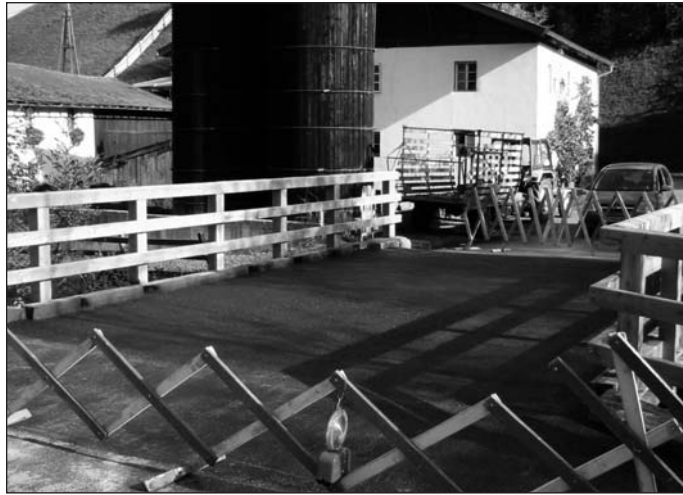
Sanierung der Sendersbachbrücke im Ortsteil Bachl
