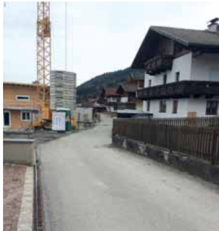
Kalchmoosweg – Blick Richtung Osten
