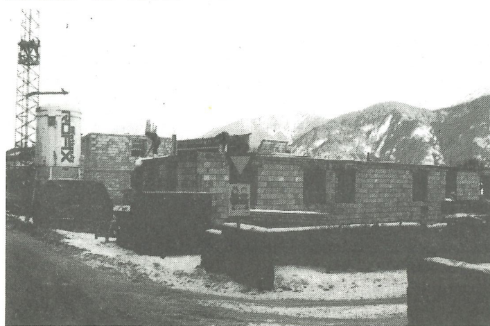
Ab Mitte Jänner konnte mit den Arbeiten am Gemeindehaus wieder begonnen werden.
