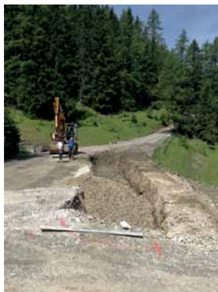
Sickermulde im Bau
