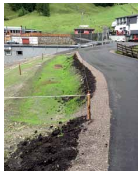
Sickermulde östlich des Zufahrtsweges zum Kompetenzzentrum 1600
