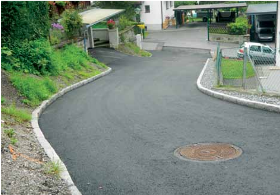
Fertiggestellte Auffahrt zum Panoramaweg im Bereich Kalchgruben
