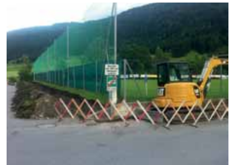
Die Stromkabel wurden platzschonend außerhalb des Fußballfeldes verlegt.
