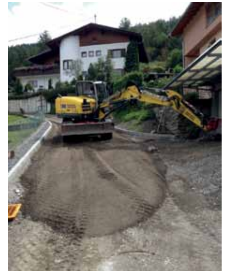
Auftragen der Feinplanie
