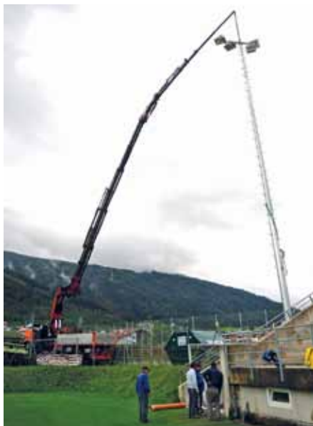
Die Mastenmontage erforderte viel Geschick.
