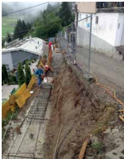
Errichtung von mehreren Stützmauern am Kirchweg
