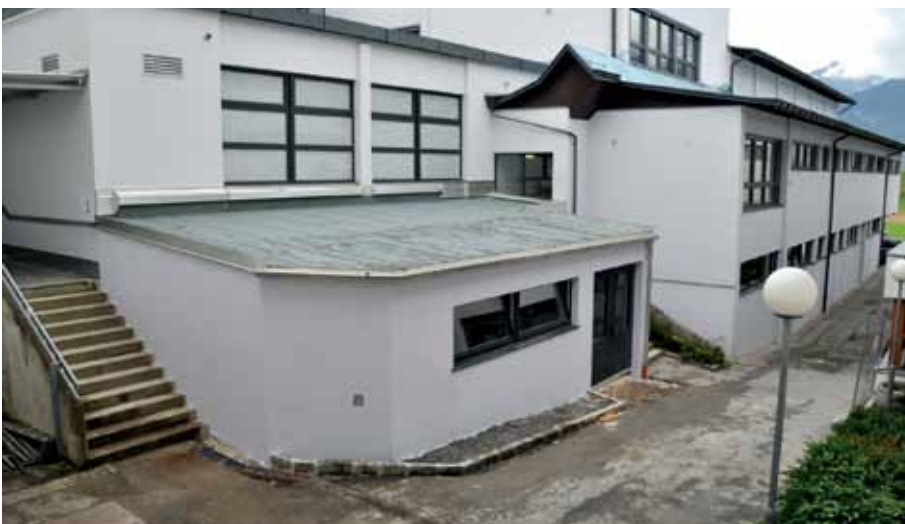
Während der Sommerferien wurde der neue Lagerraum errichtet.
