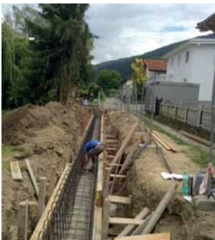
Bau der neuen Grenzmauer
