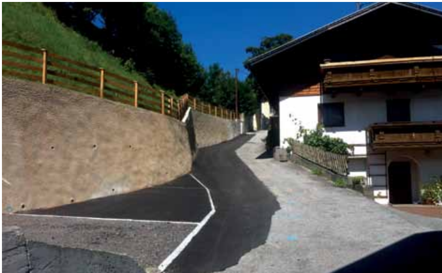
Straßenausbau mittels Spritzbetonmauer im Bereich Schnitzer's Egg (Burglechnerstraße)
