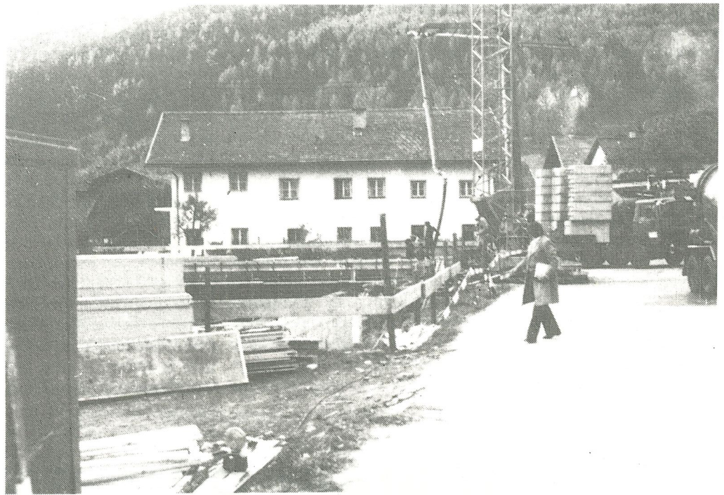
Am Axamer Gemeindehaus wird mit Hochdruck gearbeitet. Herbst 1985 soll das 25-Mio. Gebäude bezugsfertig sein.
