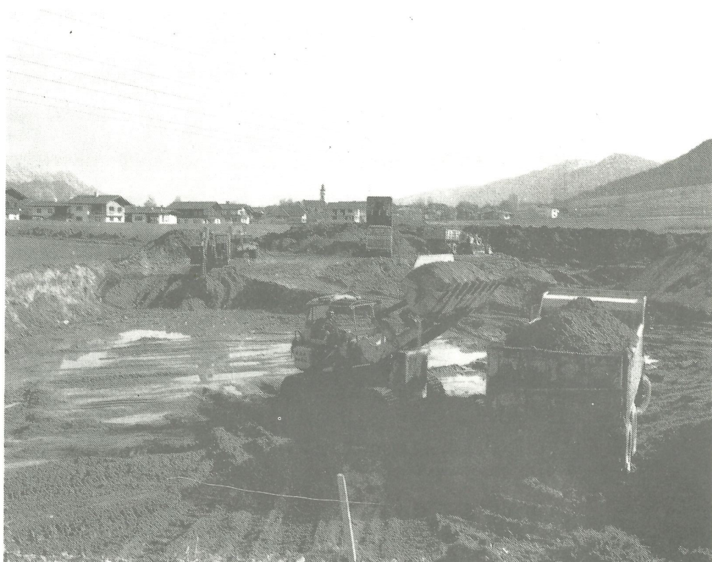
Auf Hochtouren läuft zur Zeit die Falbesoner-Großbaustelle. Nächstes Frühjahr sollen hier bereits Autos repariert werden - laut Falbesoner mit einheimischen Arbeitskräften.
