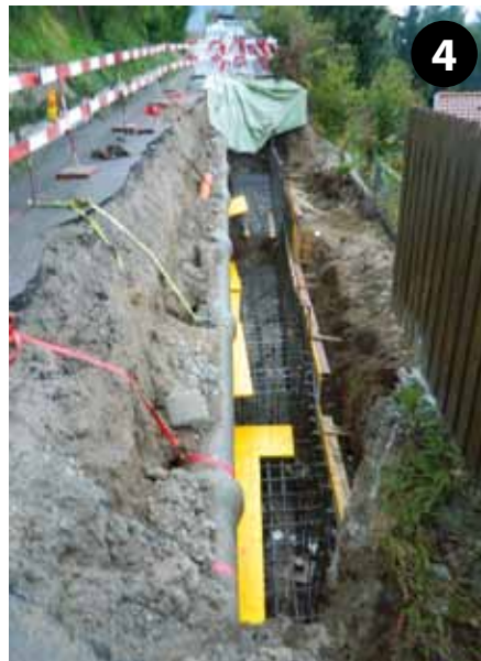
4 Fundamentbewehrung in Injektions-Bohr-Anker eingebunden
