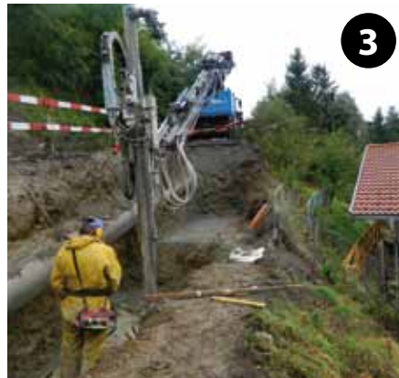
3 Bohren der Injektions-Bohr-Anker mittels Autokran der Fa. Felbermayr
