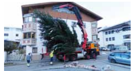
Aufstellen mit Hilfe eines Autokrans
