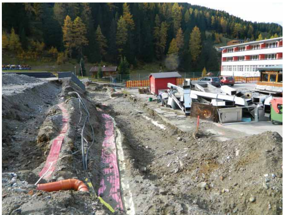
Neuer Wegabschnitt im Bereich zwischen Hotel Olympia und Hoadlbahn Talstation
