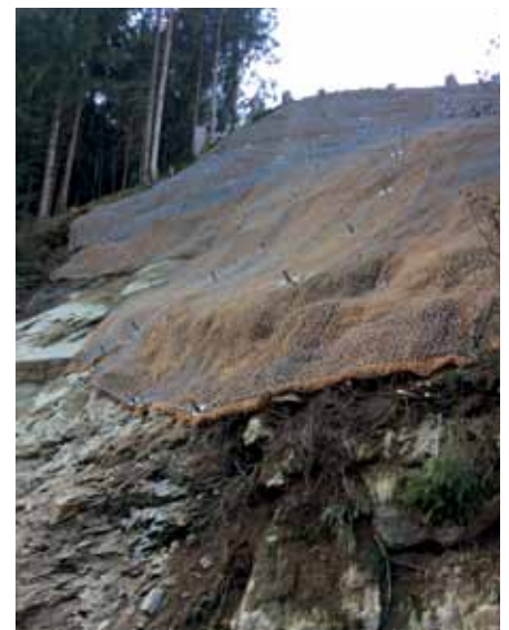
Der Erosionsbereich musste mit einer leichten Vernetzung geschützt werden.
