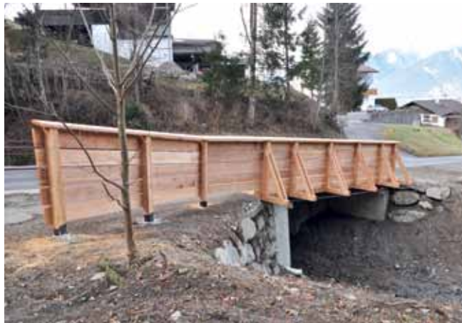
Die Fußballbrücke im Bereich Knappen wurde erneuert. Foto: Matthias Riedl
