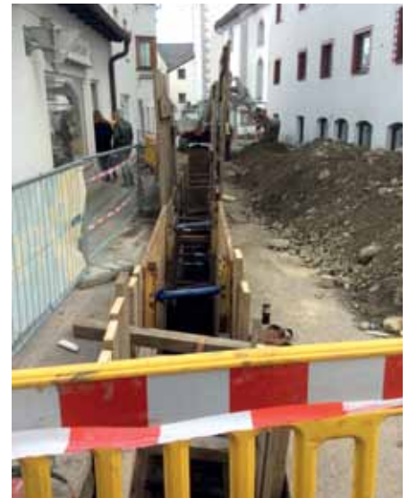
Blick von der Kreuzung Sylvester-Jordan-Straße/Burglechnerstraße Richtung Osten
