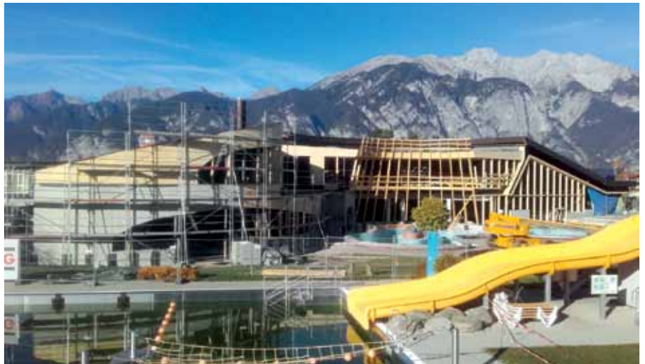
Die neue Südansicht entsteht.
