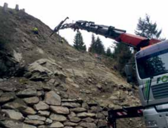
Die Arbeiten im steilen Gelände waren nicht gerade einfach. Fotos: Ing. René Sarg
