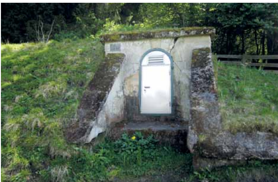
Außenansicht Zwischenbehälter – erbaut 1910
