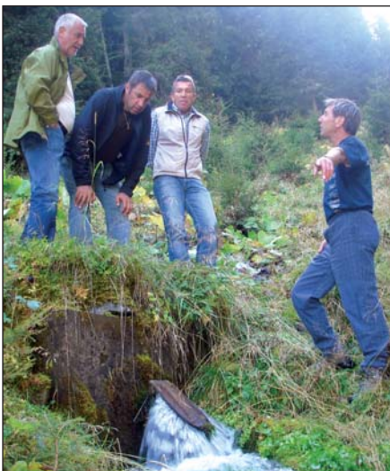
Überlauf bei Brunnenstube I
