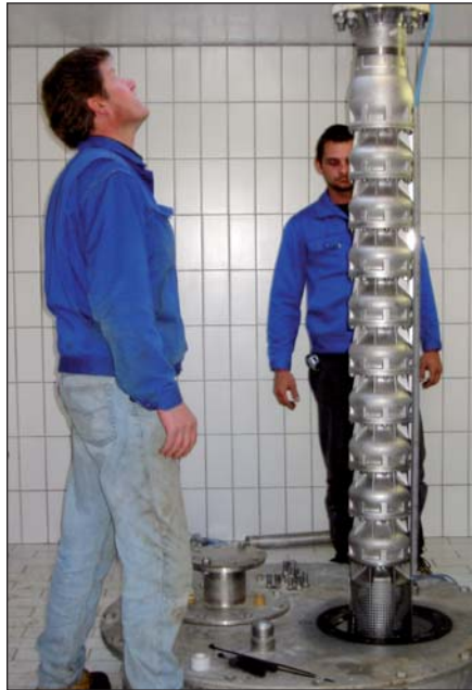
Einbau der Tauchmotorpumpe im Tiefbrunnen Ruifach
