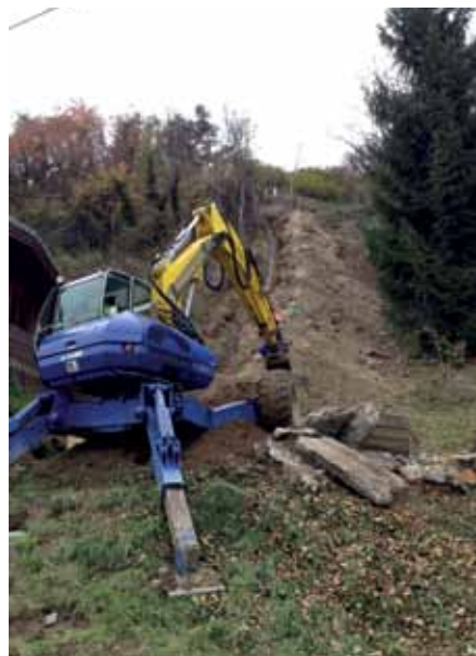
Die Grabungsarbeiten erfolgten in steilem Gelände.
