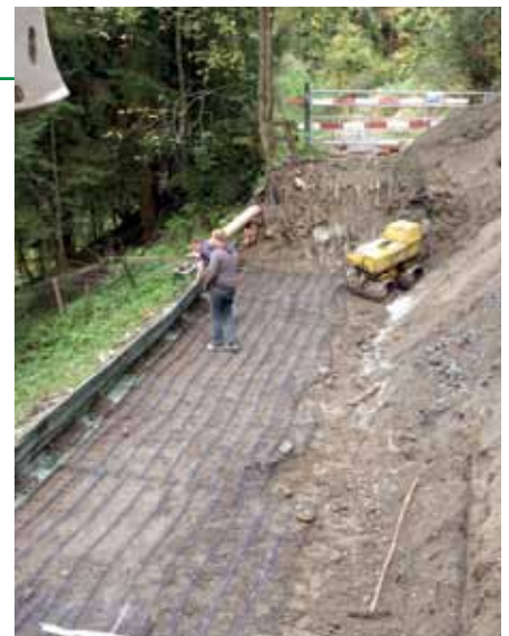
Hangbefestigung mittels bewehrter Erde am Panoramaweg
