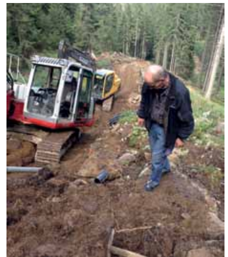
Grabung der Brunnenstube Oberes Garagg
