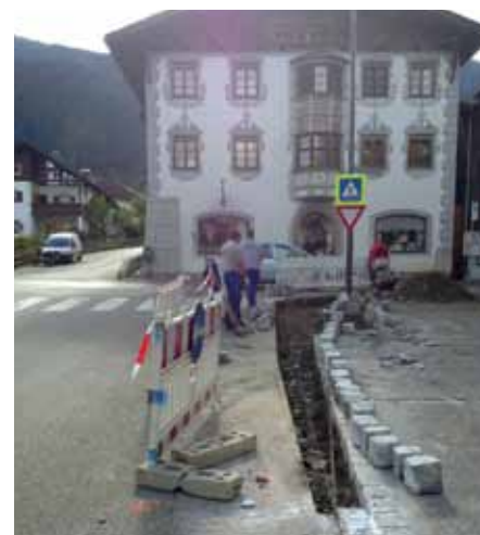
Verlegung der Randsteine
