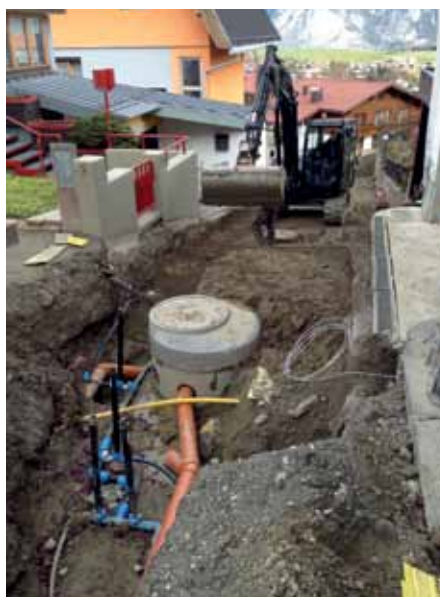
Sämtliche Leitungen wurden ausgetauscht.
