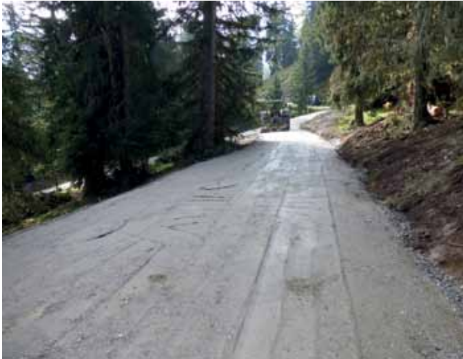
Der Lagerplatz wurde geschottert ...
