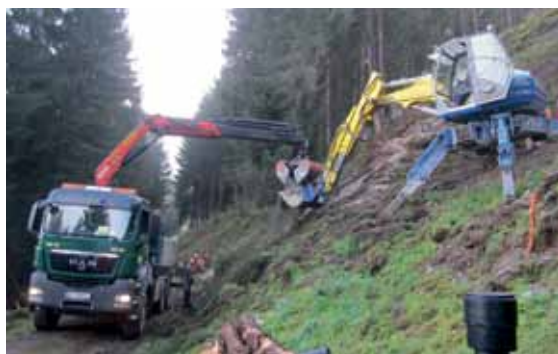
Schwierige Baggerarbeiten im Gelände
