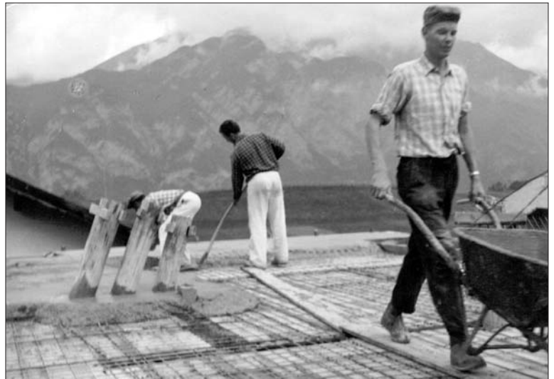
Als das Decken-Betonieren um 1960 noch reine Handarbeit war.
