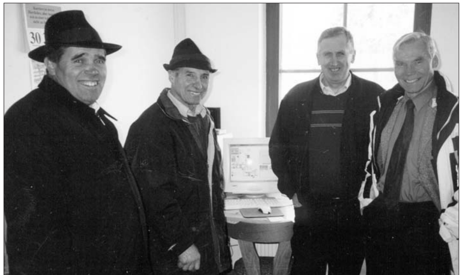
In der Steuerungszentrale der Bioheizanlage: Bgm. Rudolf Nagl, Betreiber Johann Hansmann, Vize-Bgm. Alfred Jordan (Birgitz), GR Klemens Betz.
