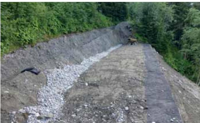
Sanierung mittels bewehrter Erde
