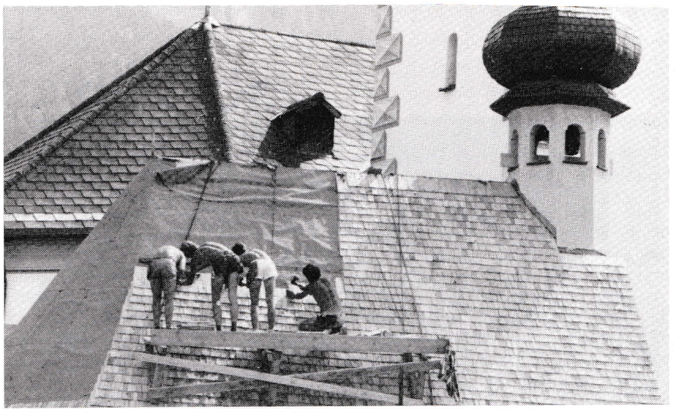
Schindel für Schindel - eine mühsame Arbeit
