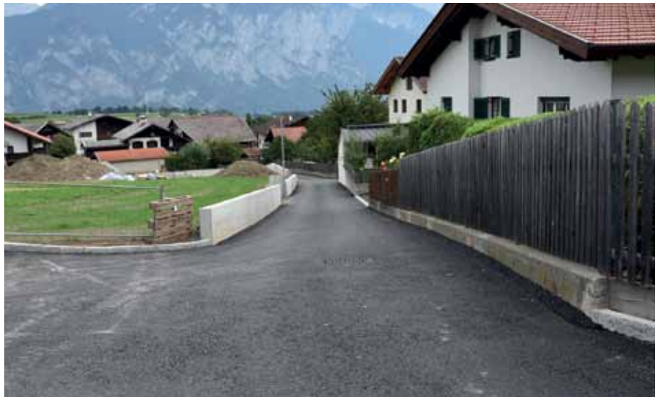
Kreuzungsbereich Baderbühelweg/Schloßgasse in Blick Richtung Norden
