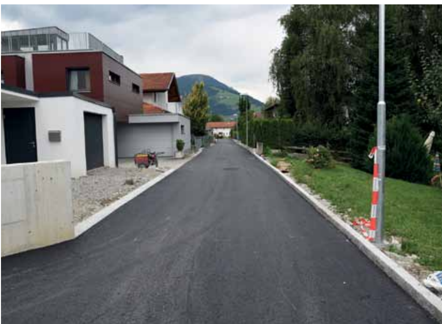
Der Schießstandweg (Blick Richtung Westen) erstrahlt in neuem Glanz.
