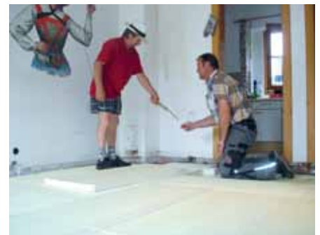
Karl Happ und Markus Kofler bei den Sanierungsarbeiten des Auswertungsraumes im Schießstand
