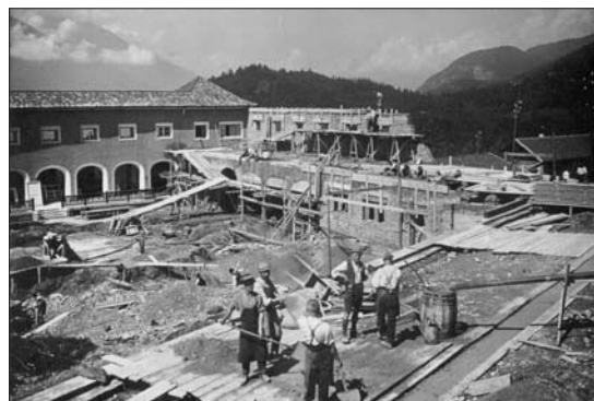
Bau der damaligen Lungenanstalt Hochzirl. Überlegearbeit für Zwischenstock.
