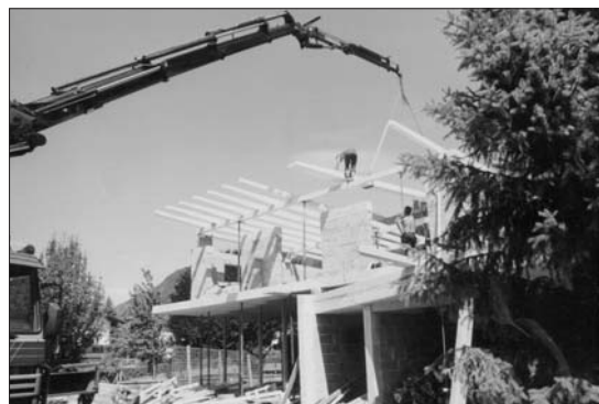
Heute werden die Dachstühle mittels Transportzeug und Kran erstellt. Bild: Thomas Leitner bei der Kranarbeit.
