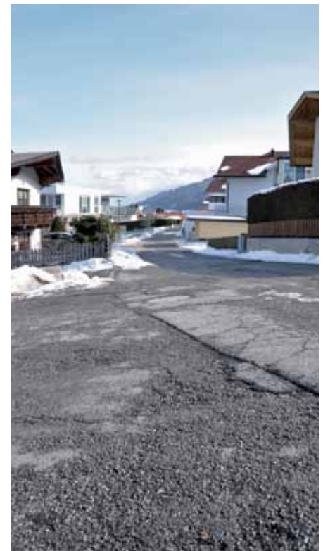
Beginnend vom Objekt Stadelbach 15 bis zur Einmündung in die Kögelestraße wird der Straßenbelag erneuert. Fotos: Matthias Riedl
