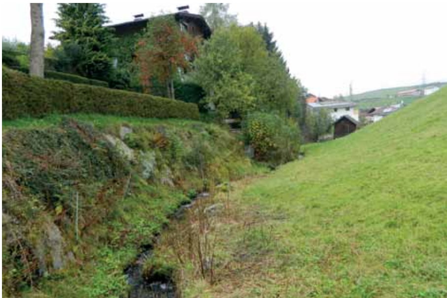
Blick in Richtung Norden – mit der Verbauung des Ruifachbachls im heurigen Frühjahr geht ein lang ersehnter Wunsch der betroffenen Anrainern endlich in Erfüllung. Foto: Ing. René Sarg
