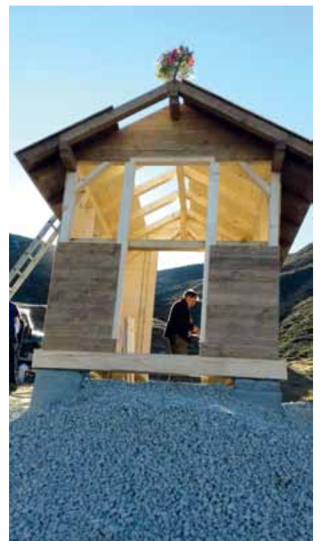
Das Starthaus kurz vor der Fertigstellung mit Firstbaum
