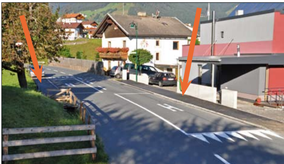
Kap-Haltestellen mit erhöhter Aufstandsfläche in Pafnitz (siehe orange Pfeile)
