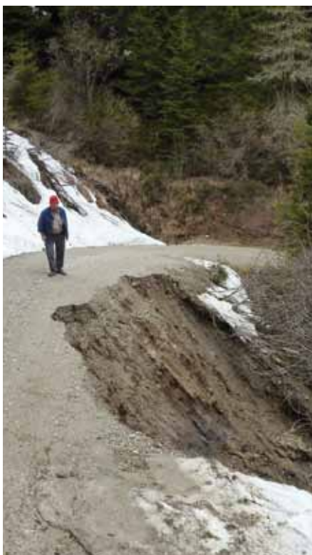
Wegschaden nach Schneeschmelze - Spieglehner
