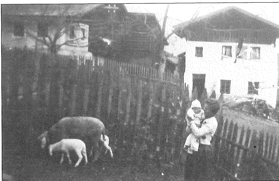
Rechts: Jagerhäusl; links hinten: „Tötscher“ in altem Bauzustand Foto: G. Wachter
