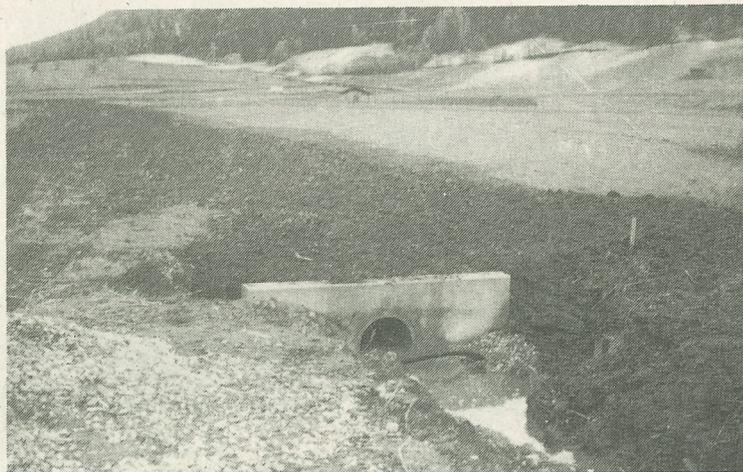
Die Verrohrung des Steinachbachls (zusammen mit dem Mühlbachl und dem Kühlerbrunnenbachl) ist fast abgeschlossen. Die Rohre sind über die Felder hinauf zum Rückhaltebecken verlegt.
