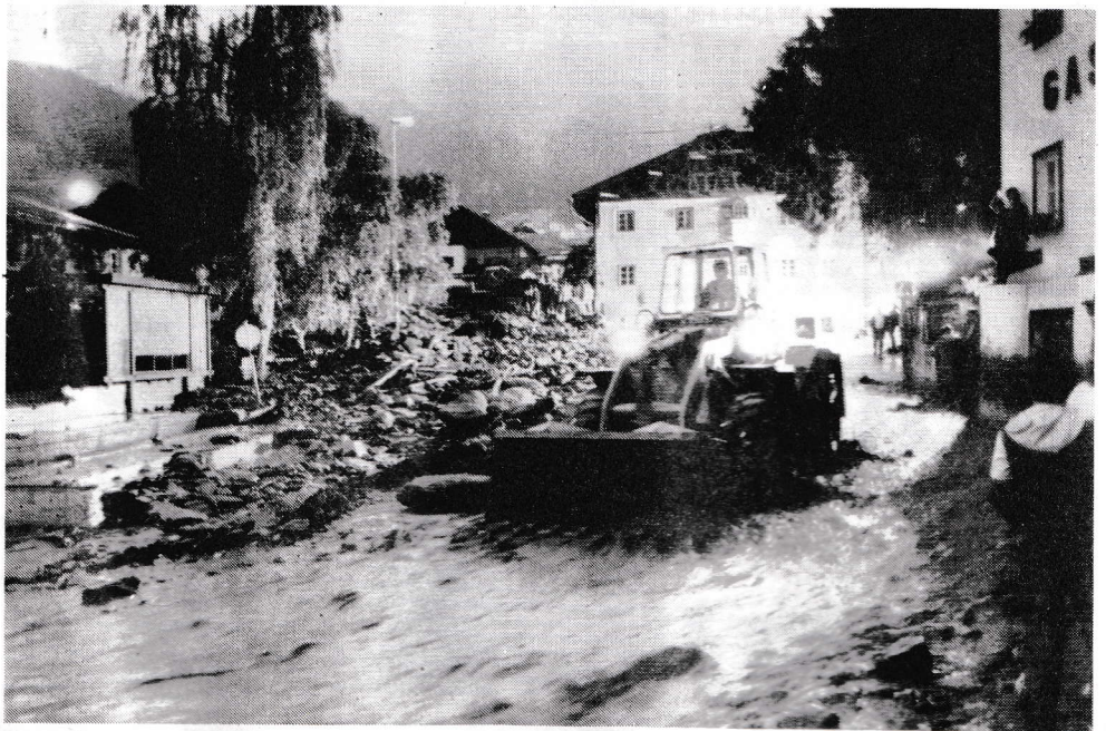
Schon in den Abendstunden fuhren schwere Baumaschinen auf.
