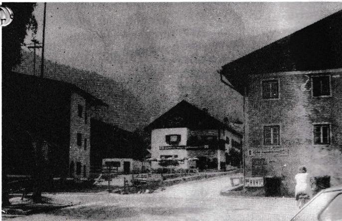
Der Dorfplatz nach den Aufräumungsarbeiten
