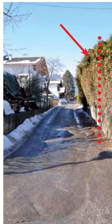
In die Straße ragende Hecken und Sträucher beeinträchtigen die Verkehrssicherheit!
