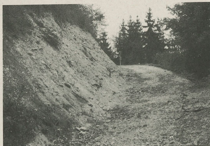
Der Weg vom Postautounkehrplatz zum Föhrenweg weist an manchen Stellen mangelnde Befestigung auf.
