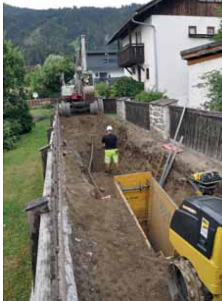
Ausführung durch die Fa. Fröschl AG
