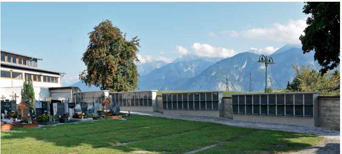
Die neue Urnennischenwand mit 80 Nischen fügt sich gut in die Umgebung ein.
