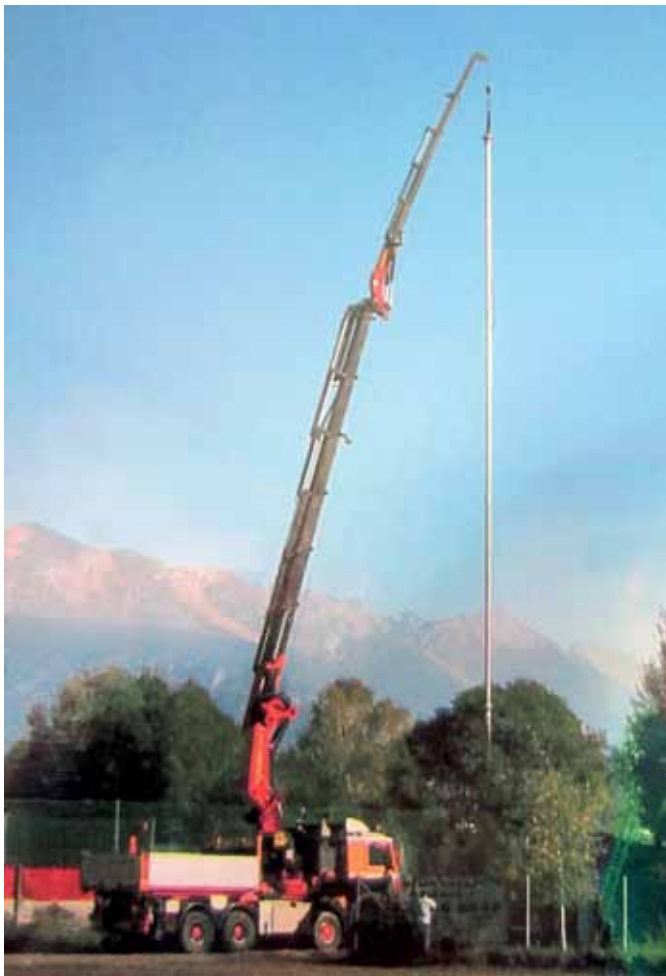
Einsetzen der 25 m langen Vertikalpumpe
