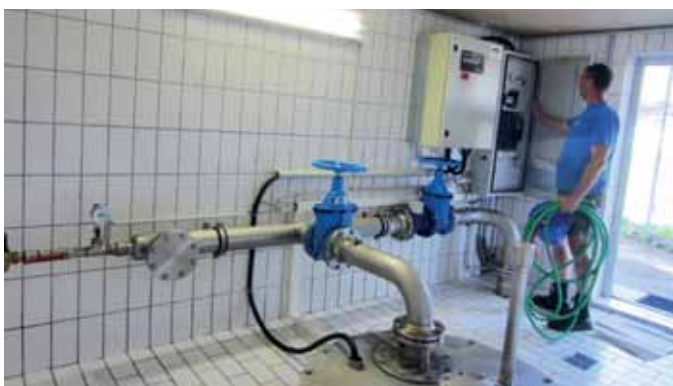
Innenraum des Brunnenhauses
