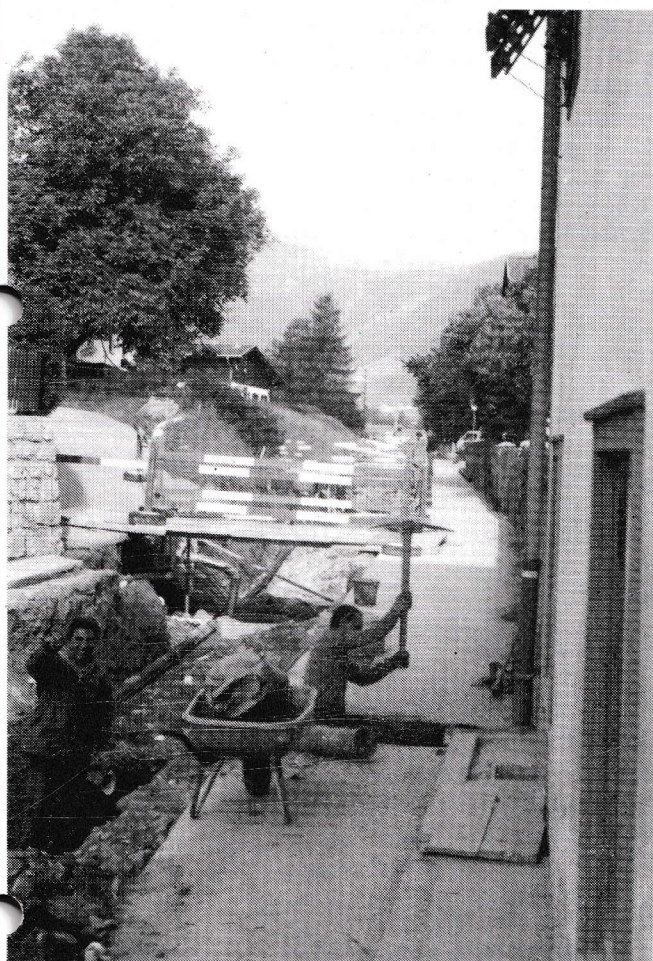
Unaufhaltsam wühlen sich die Kanal- und Wasserleitungsbauer durch das Dorf. Den betroffenen Anrainern geht es zu langsam.
