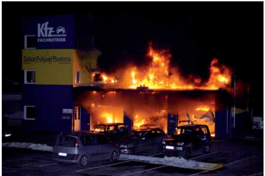
Andy's KFZ-Fachwerkstatt brannte völlig aus. Ein Übergreifen der Flammen auf die Nachbargebäude konnte verhindert werden.
