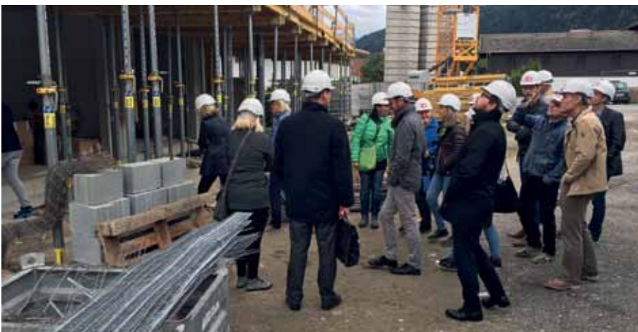
Am 14.10.2016 besichtigte der Gemeinderat den beeindruckenden Rohbau des neuen Kindergartens am Standort Mailweg.
