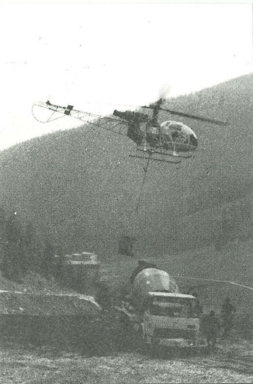
Der Betonmischwagen steht bereit, um den fliegenden Betontransporter zu beladen.
