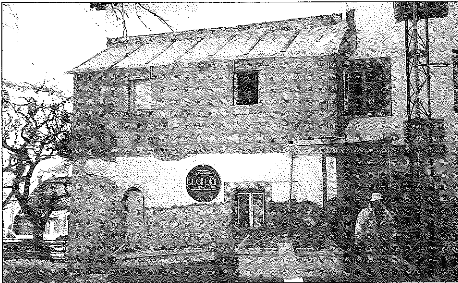
Außenarbeiten am Widum
