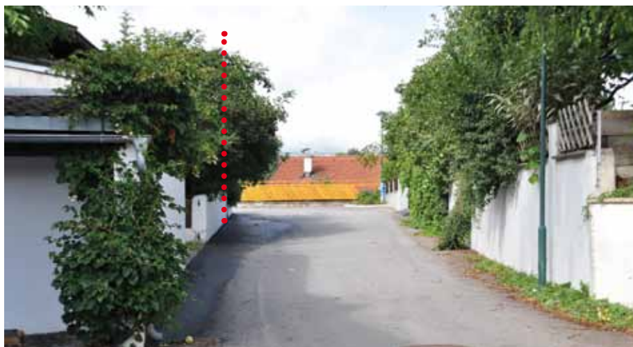
Wuchernde Sträucher beeinträchtigen nicht nur die Verkehrssicherheit, sondern behindern auch Einsatzfahrzeuge, Müllfahrzeuge, Kehrmaschinen etc. beim Durchfahren.
