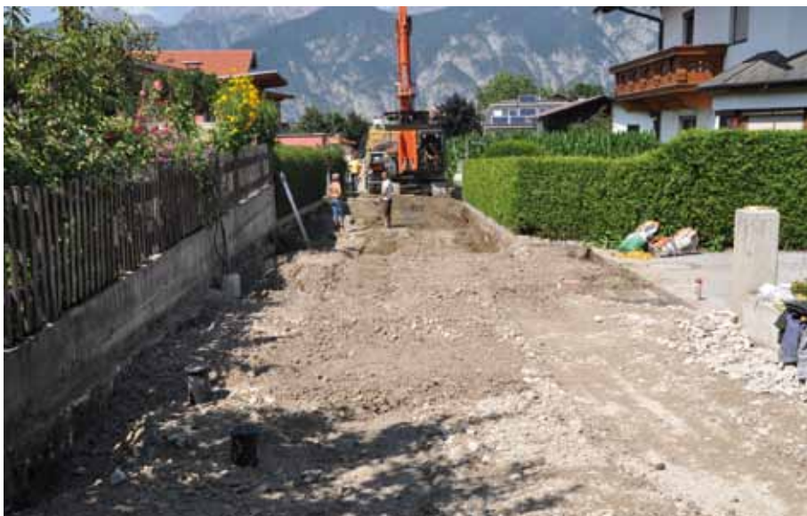
Die Bauarbeiten am Moosweg gehen dem Ende zu.
