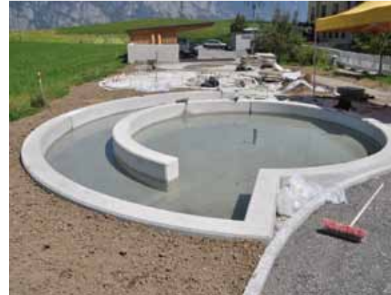
Dieses Becken soll künftig zum Kneippen einladen.
