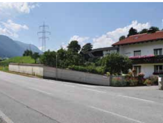
Damit ein Gehsteig mit entsprechender Breite Platz hat, wird die derzeitige Mauer zur Straße hin um einen halben Meter nach Norden versetzt.
