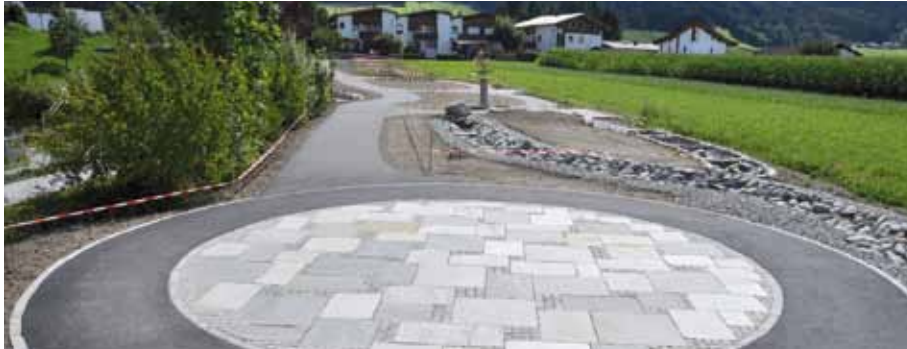
Parkanlage nach Abschluss der Pflasterungs- und Asphaltierungsarbeiten
