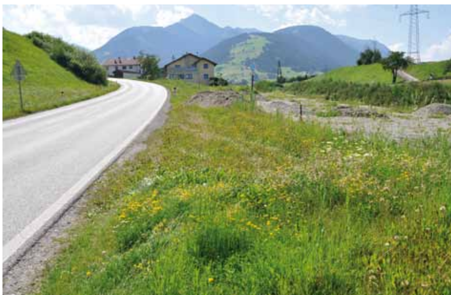
Hier entsteht eine neue Busbucht samt Gehsteig und Beleuchtung.
