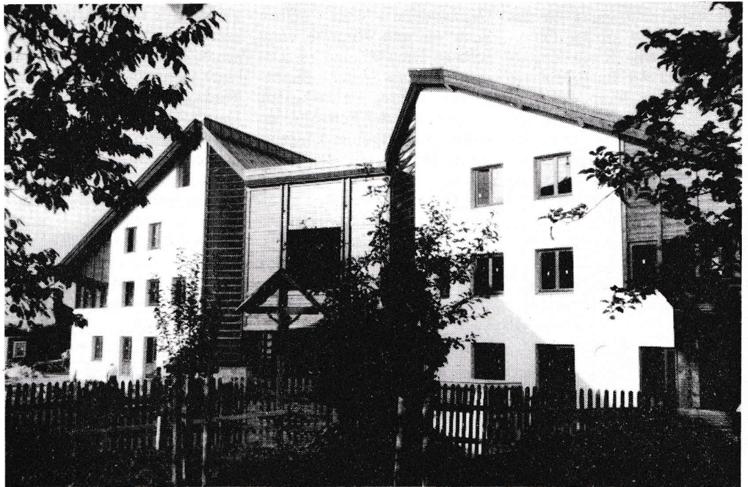
Das Gemeindehaus wird derzeit auf den letzten Schliff gebracht. Eröffnung soll am 27. Oktober sein.
