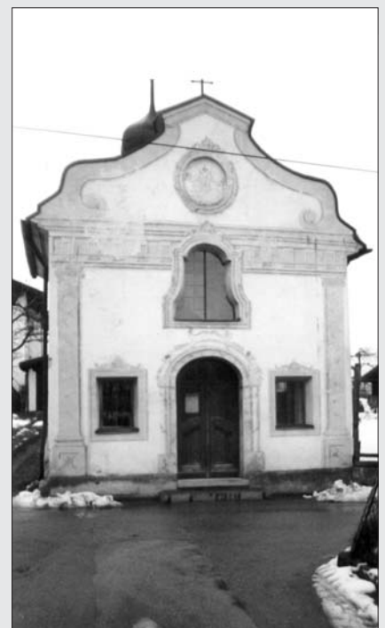
Die Omeskapelle wurde renoviert.
