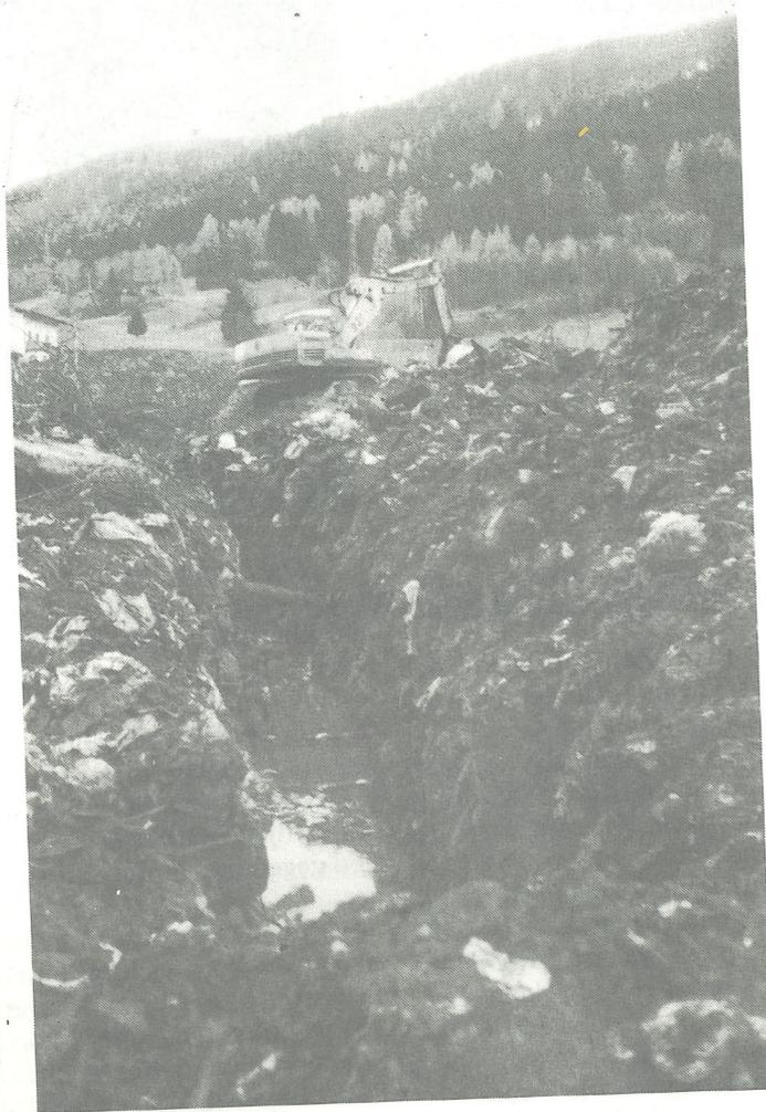
Die Ableitungsrohre sollen mitten durch die Mull verlegt werden. Im Graben sammelt sich das Wasser.
