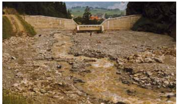
1981, also zwei Jahre vor der Katastrophe, wurde die Talsperre errichtet. Nicht auszudenken, wenn sich diese 50.000 m 3 Geröllmassen durch das Dorf gewälzt hätten.
