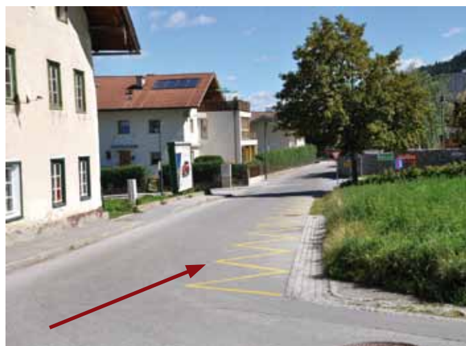
Damit das Dauerparken verhindert wird, wurden am rechten Fahrbahnrand des Baderbühelweges (im Kreuzungsbereich zur Olympiastraße) gelbe Zick-Zack-Linien markiert (siehe roter Pfeil).
