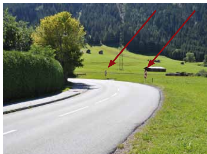
Zur besseren Ankündigung der scharfen Kurve auf der Kögelestraße wurden Leitpfosten errichtet. Zudem werden noch entsprechende Verkehrszeichen aufgestellt (siehe rote Pfeile).
