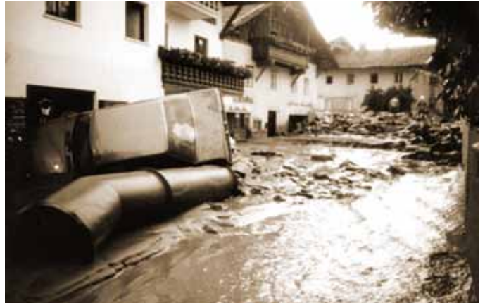
Die Gebäude Innsbrucker Str. 2 („Bieriger“) und Georg-Bucher-Str. 1 („Lutt“) mussten nach der Murkatastrophe abgerissen werden.
