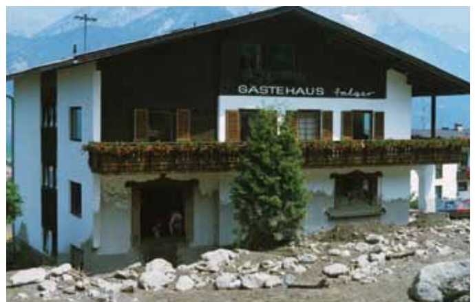
Zahlreiche Häuser wurden schwer beschädigt wie z.B. das Gästehaus Falger am Wiesenweg. Ein großes Glück, dass keine Menschen zu Schaden bzw. ums Leben gekommen sind!
