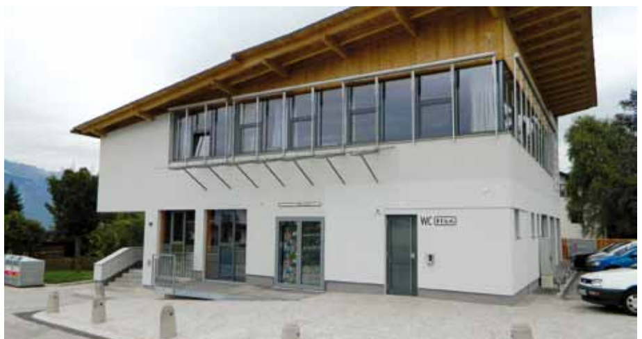
Das WC fügt sich gut zum Gesamtbild des Vereinshauses ein.
