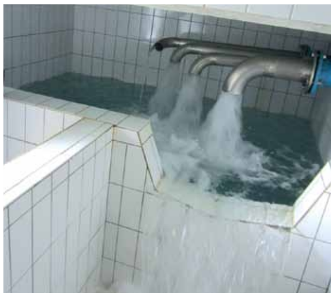
Quellstube „Garagg“ mit den Zuläufen – zur Zeit mit 24 Sekundenliter
