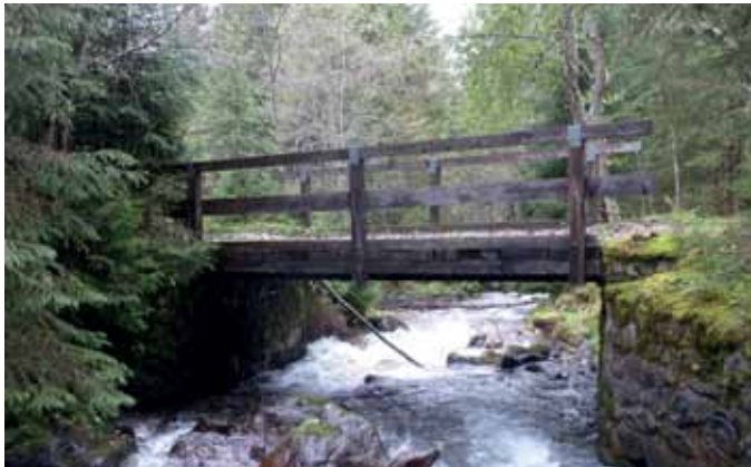
Die Gaisbrücke vorher ...
