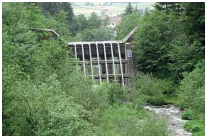
Im Stauraum ist eine Bewuchsentfernung notwendig.
