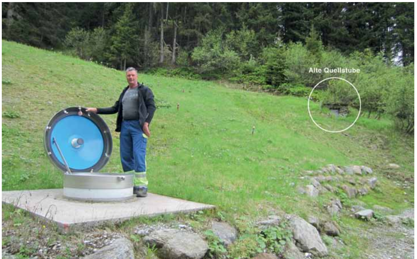
„Dunkle Rise“ mit Quellmarkierungen – rechts im Hintergrund eine alte Quellfassung aus den 50er Jahren (außer Betrieb)
