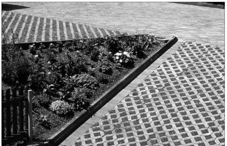
Alternative Versiegelung zur Asphaltierung
