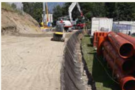
Lagenweise Herstellung der bewehrten Erde
