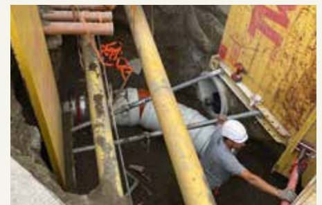
Umlegung des Schmutzwassersammlers
