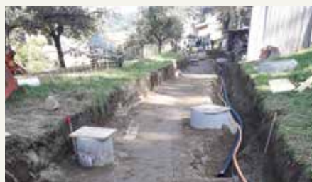
Verlegung der Leerrohre / Beleuchtungskabel / Straßenentwässerung und Herstellung des Unterbauplanums
