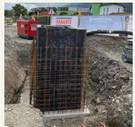
Schalungs- / Bewehrungsarbeiten für den Schacht der Druckreduzierstation
