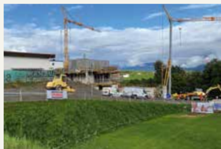
Bewuchs der bewehrten Erde
