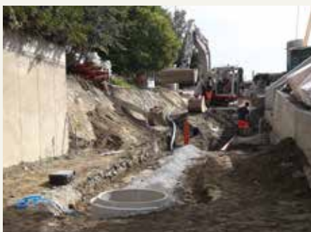
Verlegung der Straßenentwässerungsanlage
